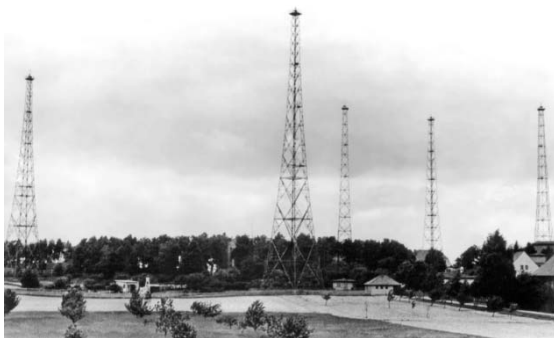
Blick auf das Observatoriumsgelände mit den fünf jeweils 80m hohen Masten der Funksendeanlage (um 1940)
