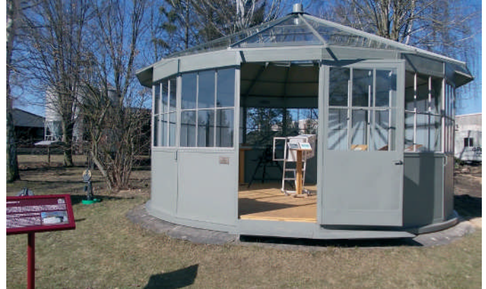
Abb. 1: Saniertes Windenhaus 2 mit Ausstellung (Foto: Stiller).
