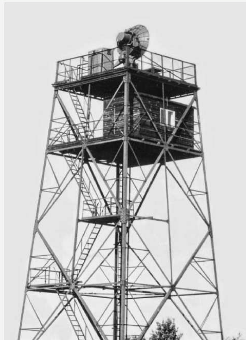
Höhenwind-Radar auf dem 30-Meter-Turm zur exakten Bestimmung der Position des Driftballons Quelle: Deutscher Wetterdienst, Archiv des Meteorologischen Observatoriums Lindenberg
